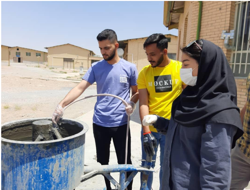
۱۸ بنده در حال ساخت بتن کنار دوستان
